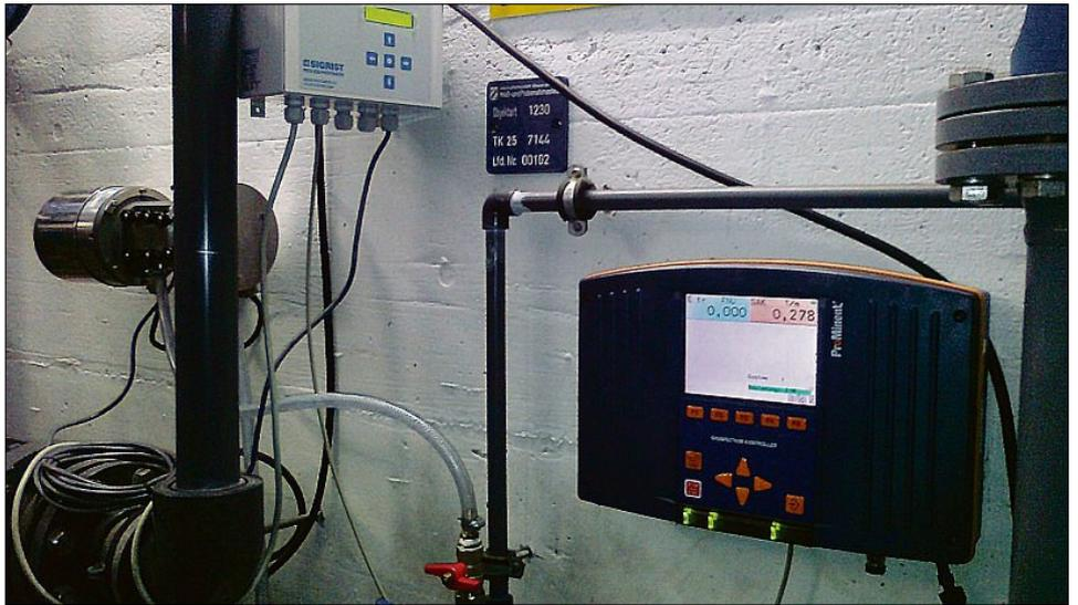
Messung und Dokumentation: Messwertfassung mit einem Photometer von Sigris sowie Anzeige und Dokumentation mit einem Disinfection Controller von ProMaqua. FOTO 852
