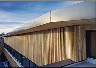
Europas größte Aufstockung in Holz. FOTO H. SCHMELER IMMOBILIEN
