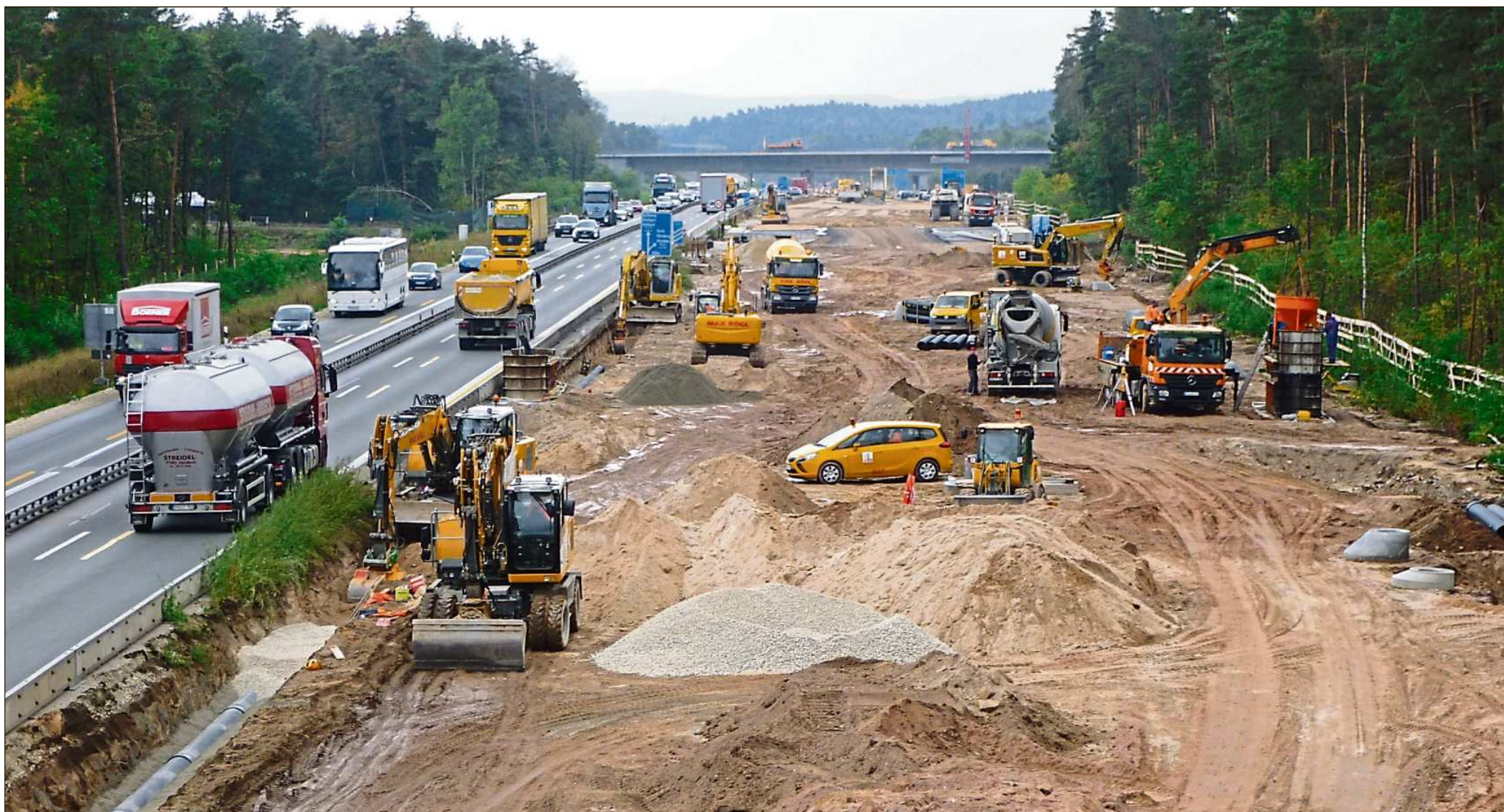
Arbeiten an der Richtungsfahrbahn Heilbronn.
