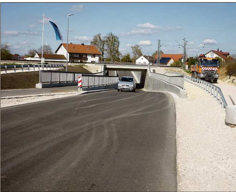
Die Situation vor Baubeginn und die fertige Unterführung.
