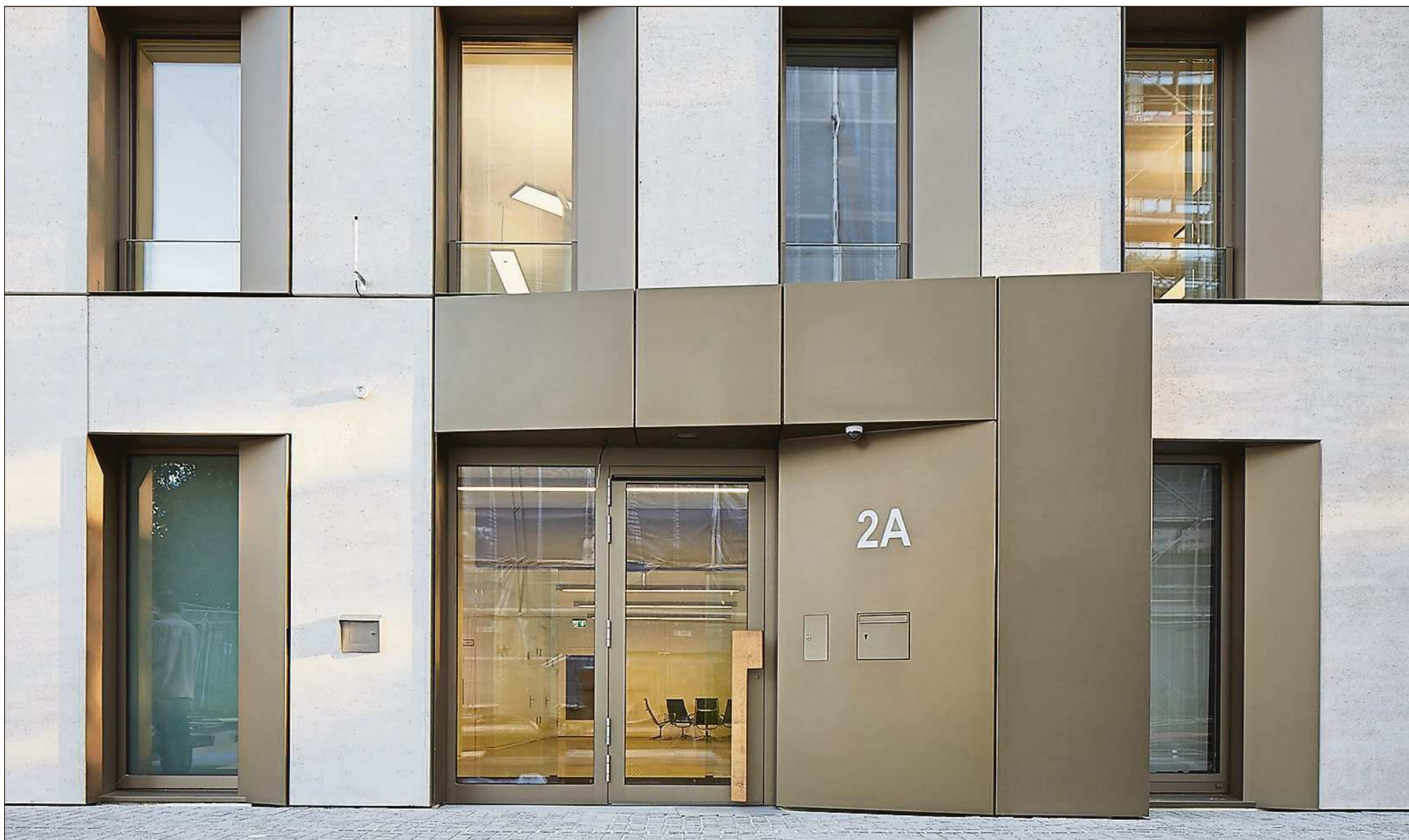
Der Eingangsbereich des Neubaus.
