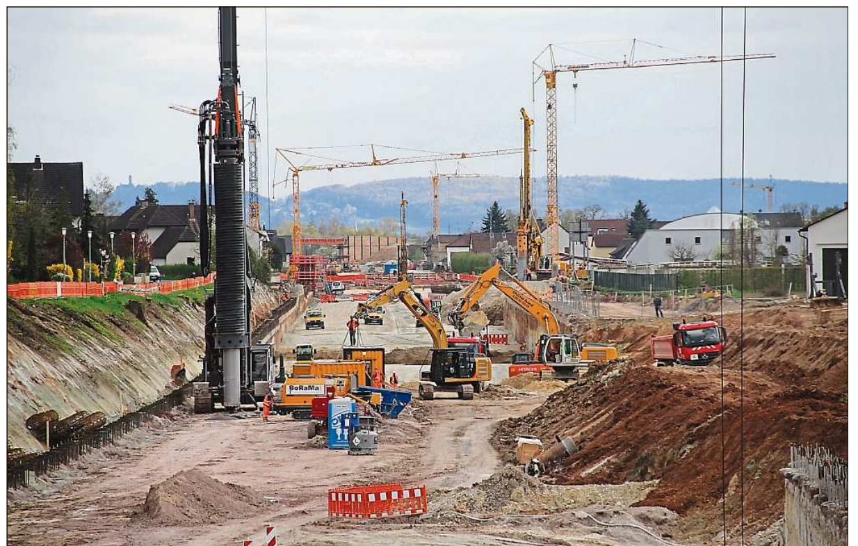
Viergleisiger Ausbau in Breitengüßbach (April 2016).
