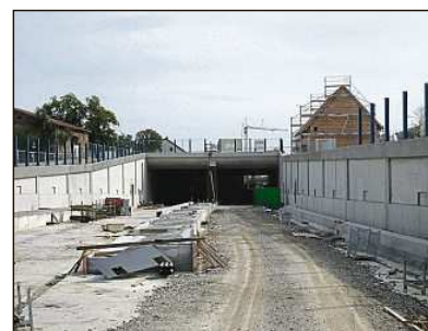
Tiefanlage mit Betriebsgebäude.
