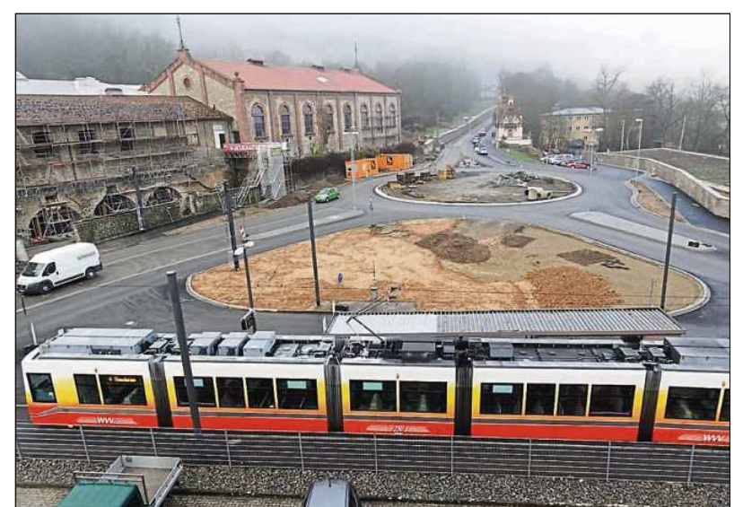
Während der Bauphase und der Kreisel kurz vor der Fertigstellung.
