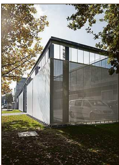
Betriebshoffassade mit Kettenhemd.
