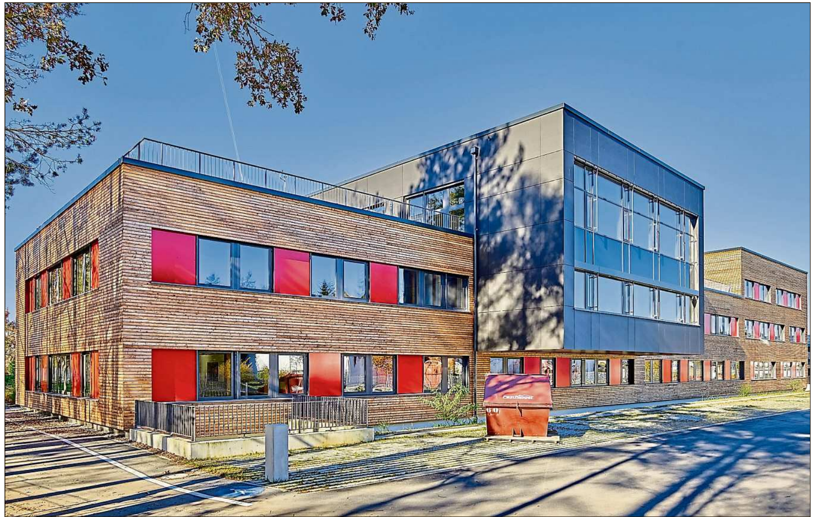
Das neue Verwaltungsgebäude in Salzweg.
