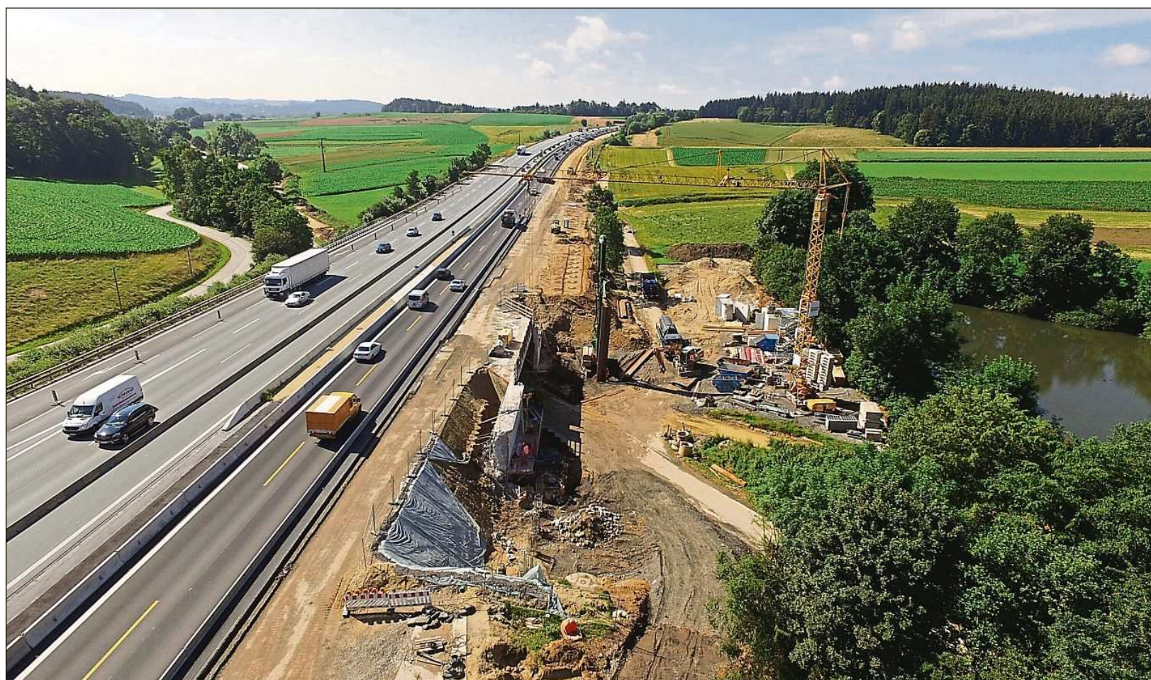
Der Seitenstreifen kann künftig als zusätzliche Fahrspur benutzt werden.
