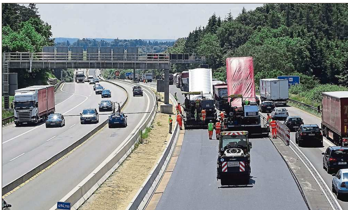
Der Einbau des Dünnschichtbelags.
