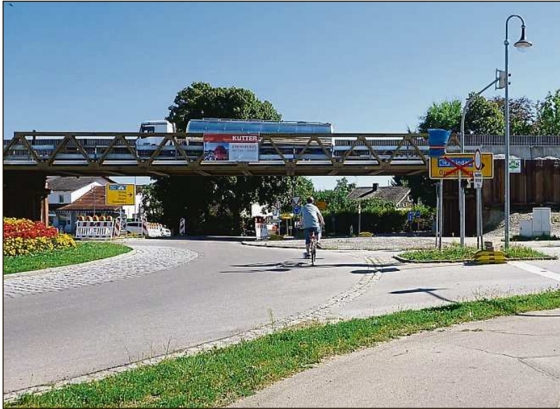
Die Behelfsbrücke in Eching.
