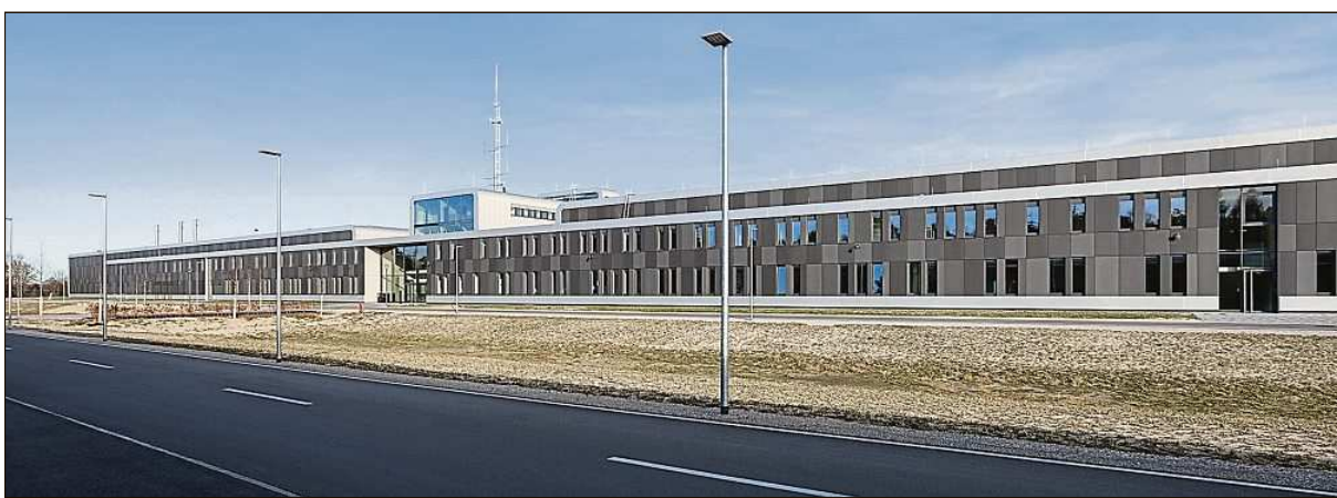
Gesamtansicht von Westen.
