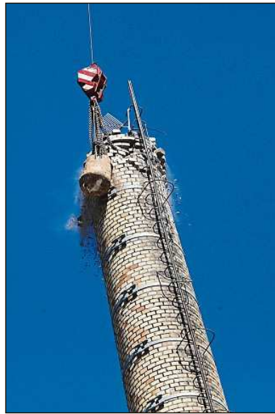
Der Abbruch des Schlots.
