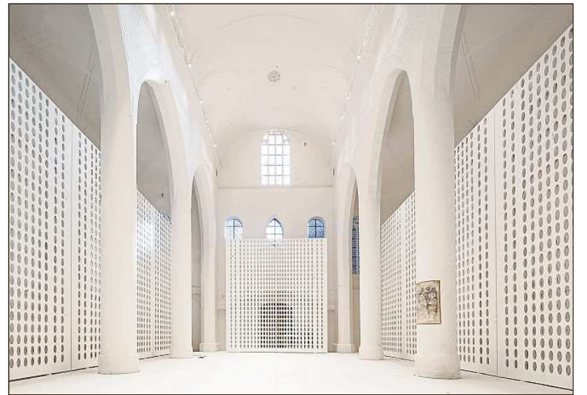
Die sanierte, ehemalige Dominikanerkirche.
