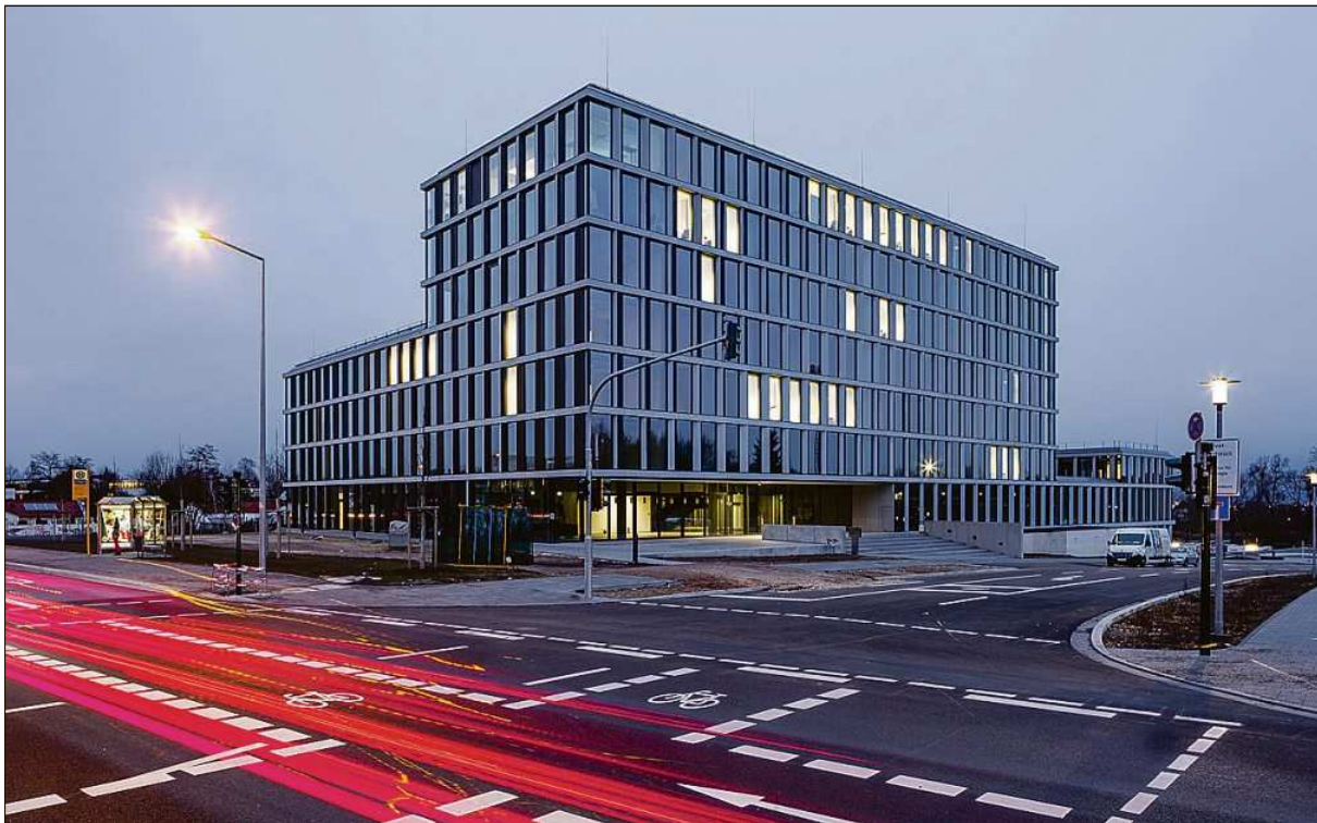
Das neue Innovationszentrum TechBase in Regensburg.
