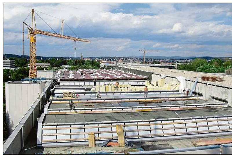
Blick auf einen Teilbereich der Dachsanierung.
