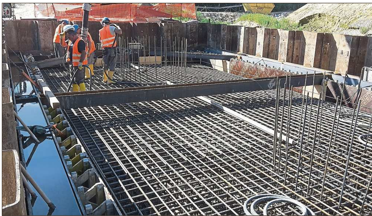
Betonierarbeiten an der Brücke über das Weidenbachtal.
