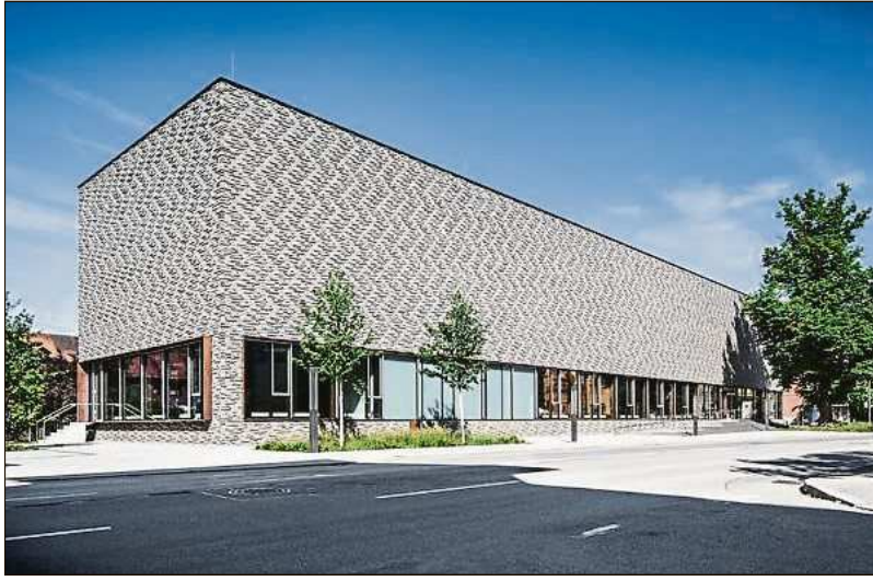
Ansicht von der Schlachthofstraße.
