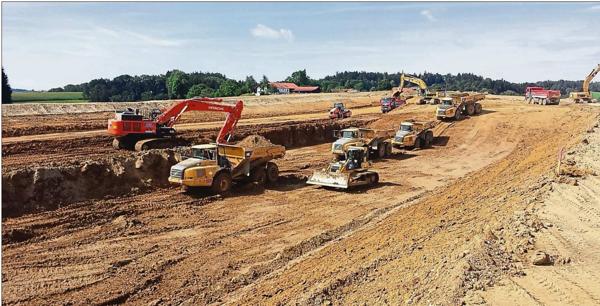
Erdarbeiten am Pausenberg, einem Einschnittsbereich zwischen Dorfen und Lengdorf.
