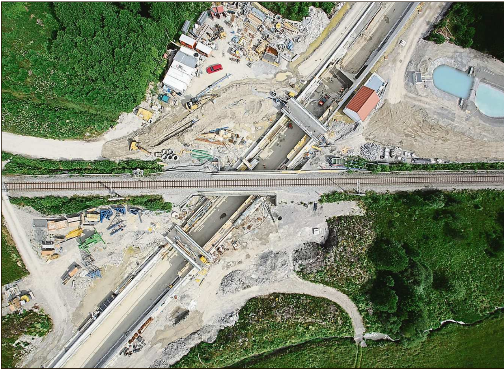
Bahnbrücke mit Wirtschaftswegbrücken und Grundwasserwanne.
