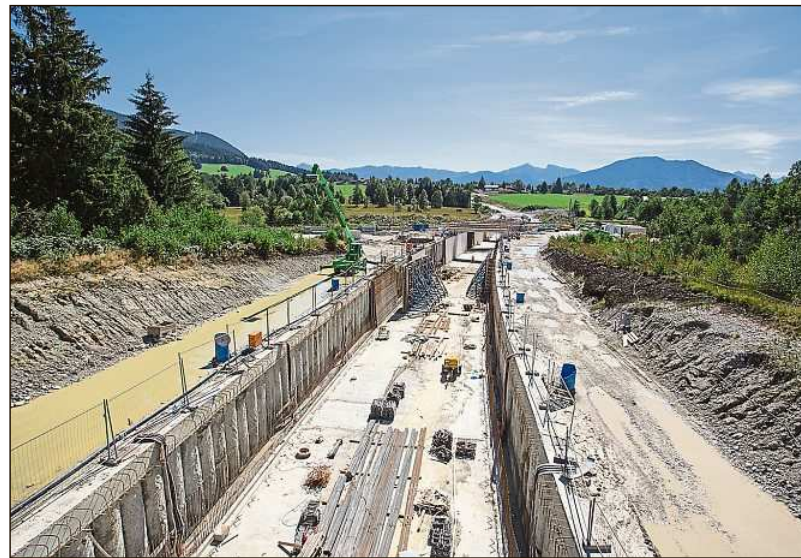
Bau der Grundwasserwanne.
