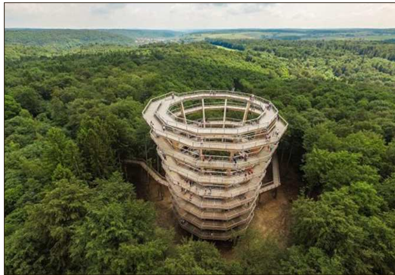
Der kelchförmige Holzturm.
