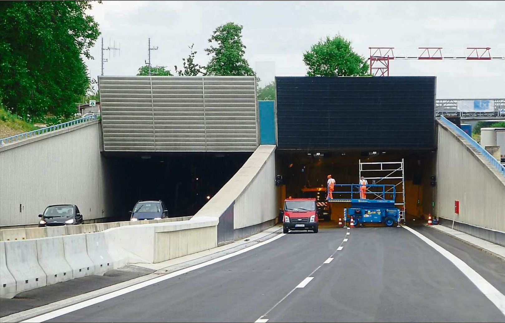
Das Portal des Tunnels Etterschlag.
