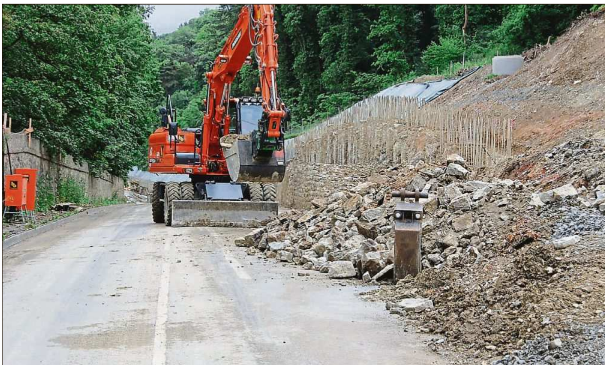
Baustelle Zeller Bock.
