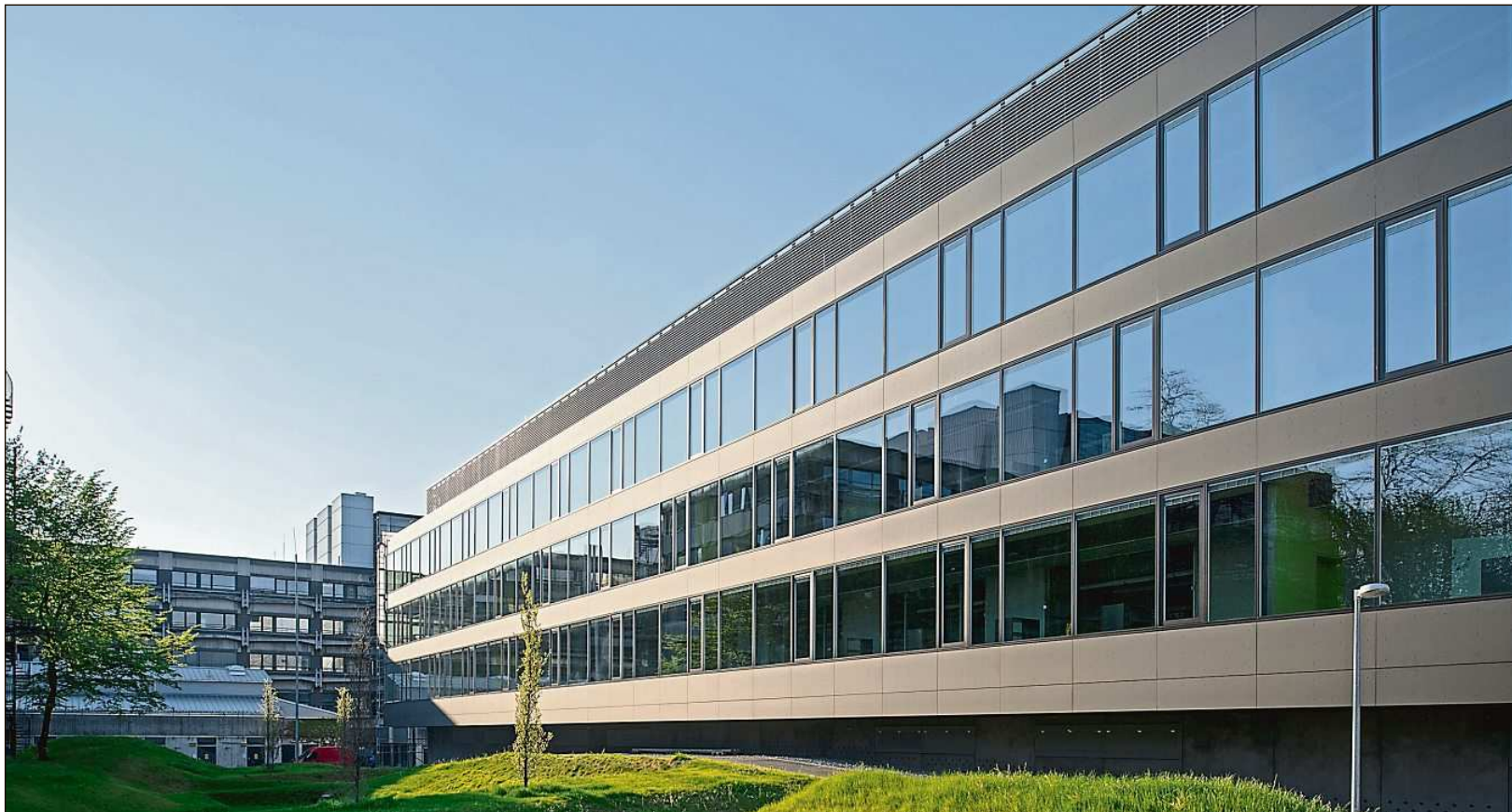
Die Südfassade des neuen Zentrums für Katalyseforschung.
