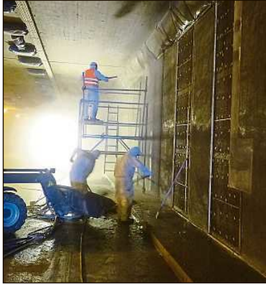
Der Auftrag des Spritzbetons für den kathodischen Korrosionsschutz mit Fremdstrom.
