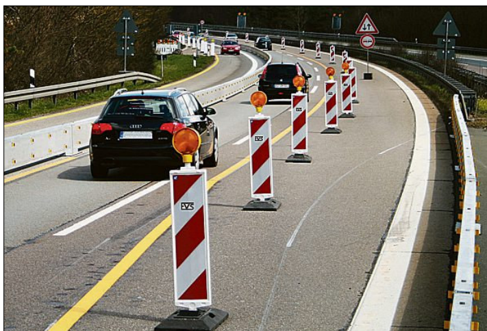
Auch bei Baustellenabsicherungen ist ein Vergabeverfahren nötig.
