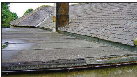
Welche Dachabdichtungsbahnen verwendet werden, kann im Rahmen einer Ausschreibung durchaus genau beschrieben werden.
