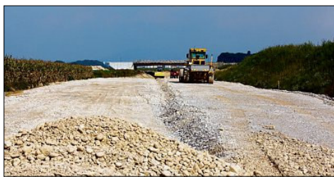
Fristen sind bei Bauleistungen entscheidend.
