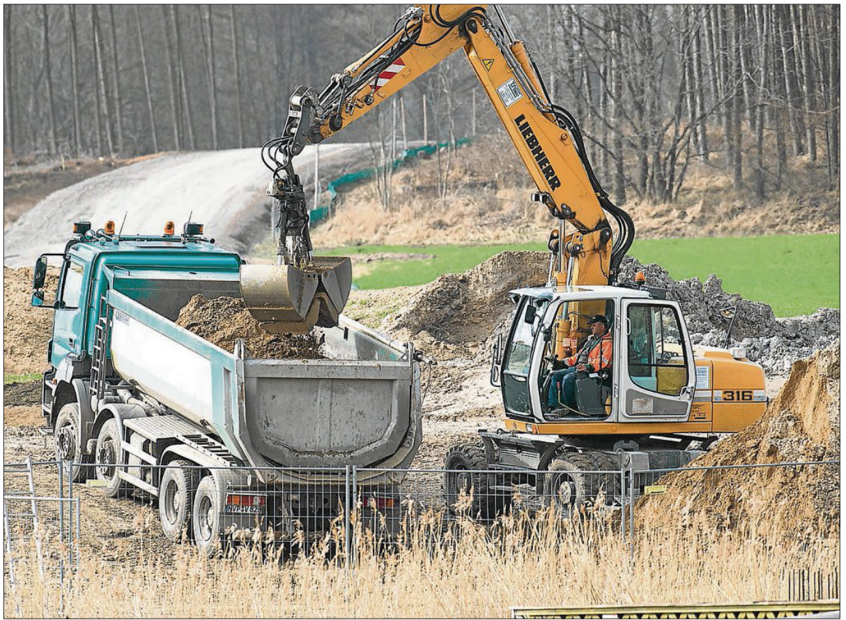
Wer Tiefbauarbeiten ausschreibt, muss auch über eventuelle Bodenkontaminationen informieren.
