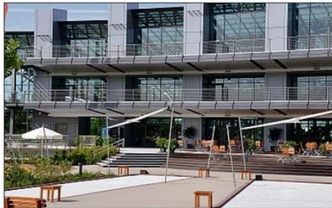
Neue Platten aus Naturstein wurden verlegt.
