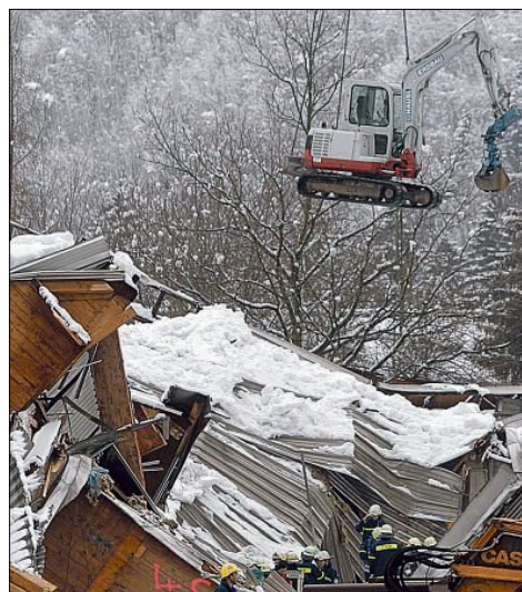
Nach dem Einsturz wird ein Bagger zu den Trümmern der Eissporthalle in Bad Reichenhall von einem Kran herabgelassen.
