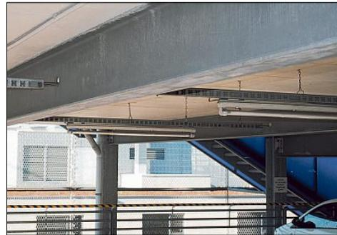
Das Feuerverzinken hält auch den extremen Korrosionsbelastungen im Parkhausbau mühelos stand.
