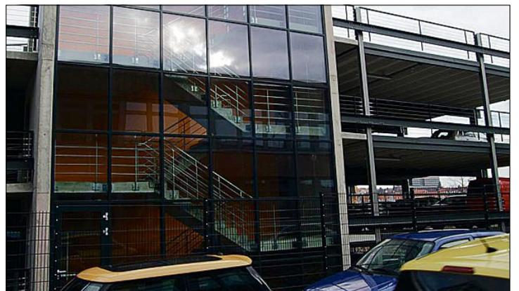
In Würzburg an der Schürerstraße hat die DIP beispielsweise 196 Stellplätze auf acht Halbebenen in Split-Level-Bauweise mit einem Treppenhaus in Stahlbeton samt Glasfassade realisiert. FOTO DIP
