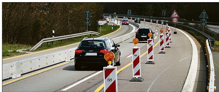
Mobile Schutzwände sorgen für Sicherheit an Autobahnbaustellen.
