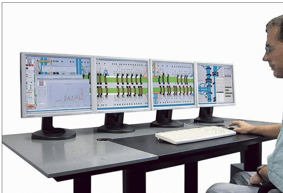
Die Zukunft der Verkehrsbeeinflussung integriert viele Systeme. Verkehrsrechner unterstützen die Überwachung. Die Säule (unten) dient als Parkscheinautomat und Ladestation.
