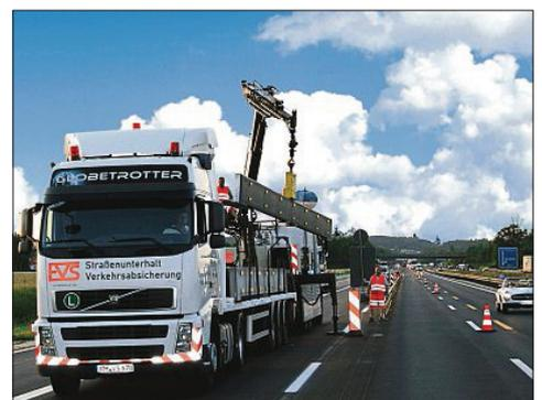
Eine mobile Schutzwand wird errichtet. Die Schutzwand bietet einen starken Übergang von einem ProTec-System auf das andere (siehe Foto unten). Dem Verkehrsteilnehmer fällt dieser kaum auf, da die Reflektoren konsequenterweise in gleicher Höhe fortgesetzt werden.
