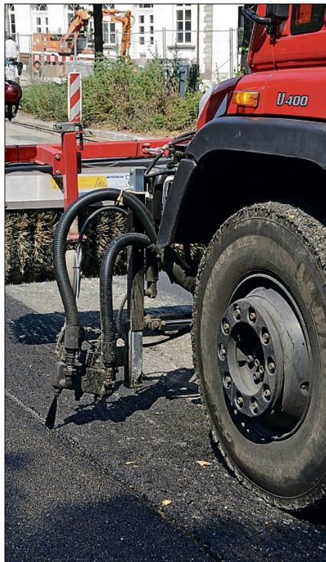
Exakte Millimeterarbeit ist beim Ausbringen des Nahtklebers (siehe kleine Düse) für den qualitativ einwandfreien Anschluss der nächsten Asphaltbahn gefragt. FOTO E.B.
