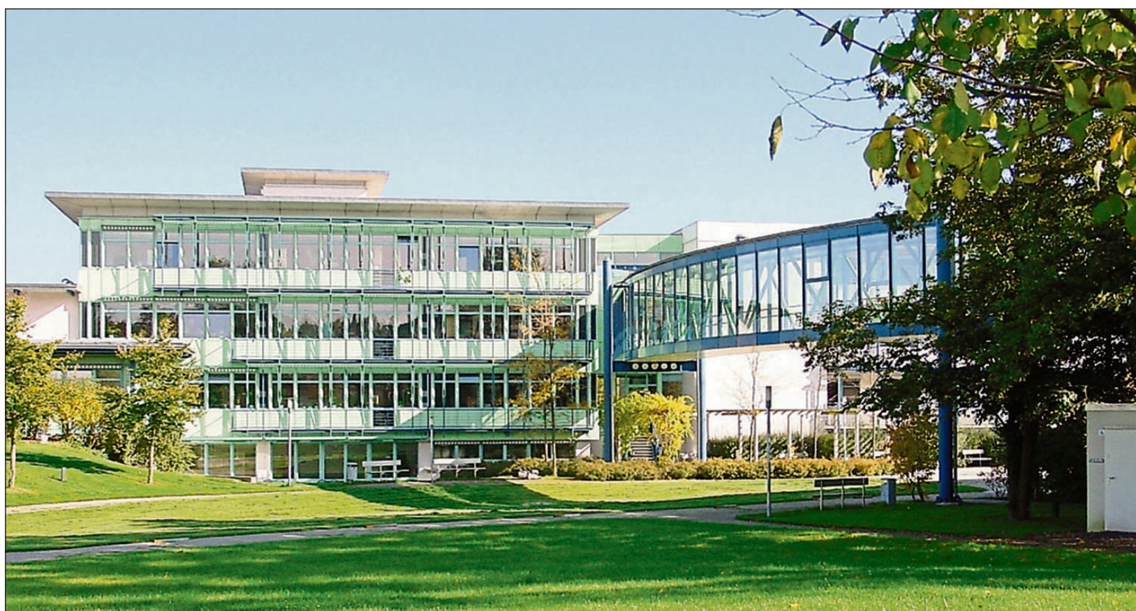
500 Mitarbeiter arbeiten in dem Akutkrankenhaus und in der Rehabilitationsklinik mit insgesamt 111 Betten.
