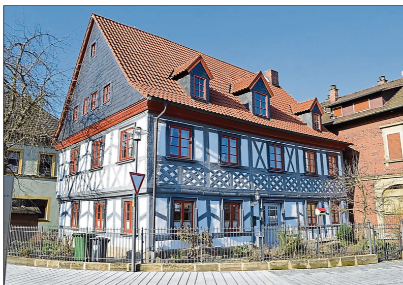
Das Haus von Gernot Hesselbarth in Lichtenfels wurde durch eine ebenso aufwendige wie vorbildliche Sanierung zum Juwel. Familie Hesselbarth wurde dafür dreifach prämiert. FOTO: HESSELBARTH
