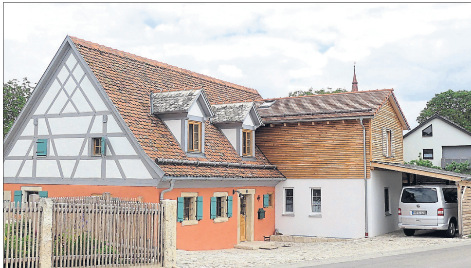
Nach langjähriger Nutzung als kleines Einzelhandelsgeschäft verkaufte die Stadt Weimersheim dieses eingeschossige, circa 200 Jahre alte Bauernhaus im Ortsteil Weimersheim an eine Privatperson. Bedauerlicherweise stand das Gebäude daraufhin jahrzehntlang leer und verfiel zusehends. Bis die neuen Eigentümer, eine Zimmermannsfamilie aus dem Ort, den Verfall nicht mehr länger mit ansehen konnten. Trotz der immensen Schäden erwarben sie das ruhmreiche Häuschen und setzten es mit eigenem Können grundlegend und fachmännisch instand.
