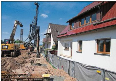
Bohrarbeiten für die Lärmschutzwand direkt an der Wohnbebauung.
