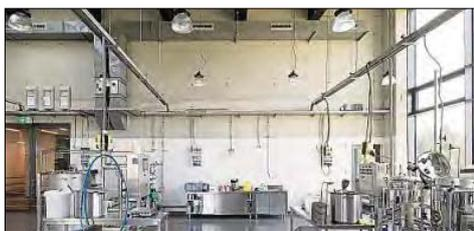
Herzstück ist das Brautechnikum. Dort stehen die brautechnischen Anlagen, die für die Herstellung der Getränke bis hin zu deren steriler Abfüllung benötigt werden.
