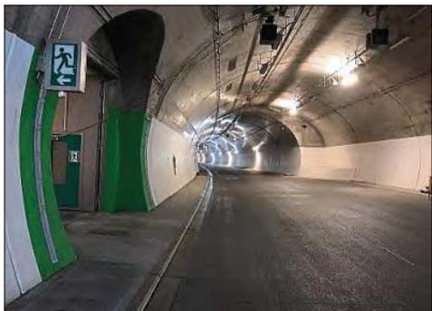
Im Tunnel findet ein umfassendes Sicherheits- und Rettungskonzept Anwendung: hier einer von zehn Rettungsquerschlägen.
