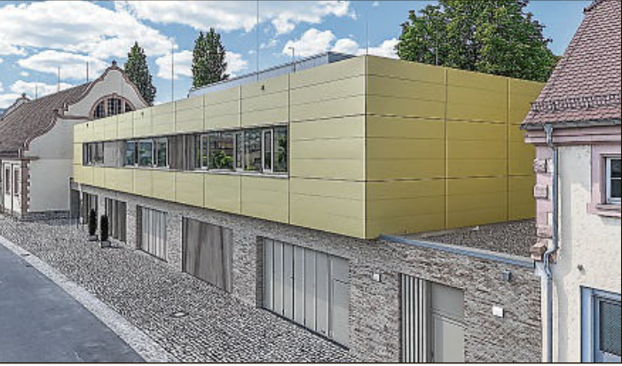
Der Neubau befindet sich zwischen zwei denkmalgeschützten Gebäuden. FOTO: STAATLICHES BAUAMT WÜRZBURG, THOMAS GÜRA
