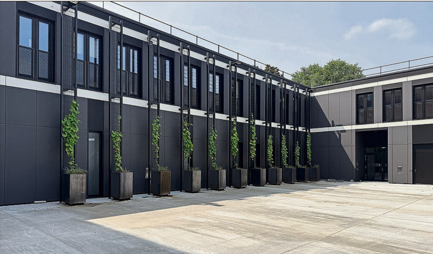
Der Polizeihof bietet viel Platz für die Dienstfahrzeuge. Aufgrund des benötigten Platzes wurde hier eine Fassadenbegrünung angelegt, die außerdem für ein gutes Raumklima sorgt.
