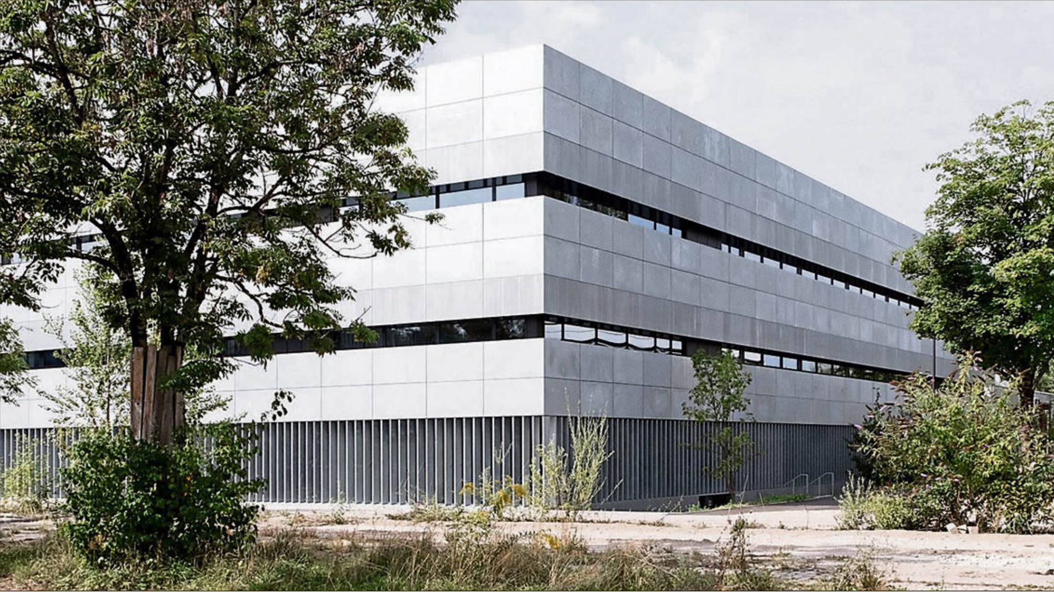
Die äußere Hülle besteht aus vorgehängten, verzinkten Metalltafeln und Lamellen, die den technischen Charakter des Gebäudeinhalts nach außen transportieren.
