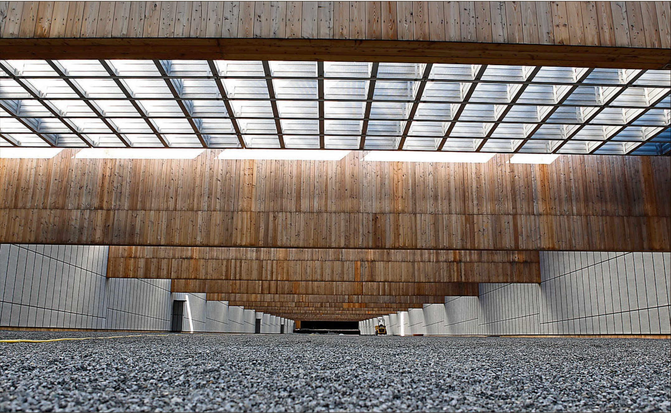
Schallabsorbierend und rückprallsicher – Blick in den 250 Meter langen A-Stand.
