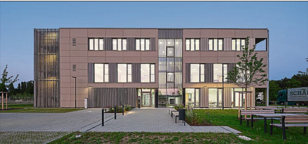
Die School of Health ist als Modulbau errichtet worden. FOTO: STAATLICHES BAUAMT ERLANGEN-NÜRNBERG
