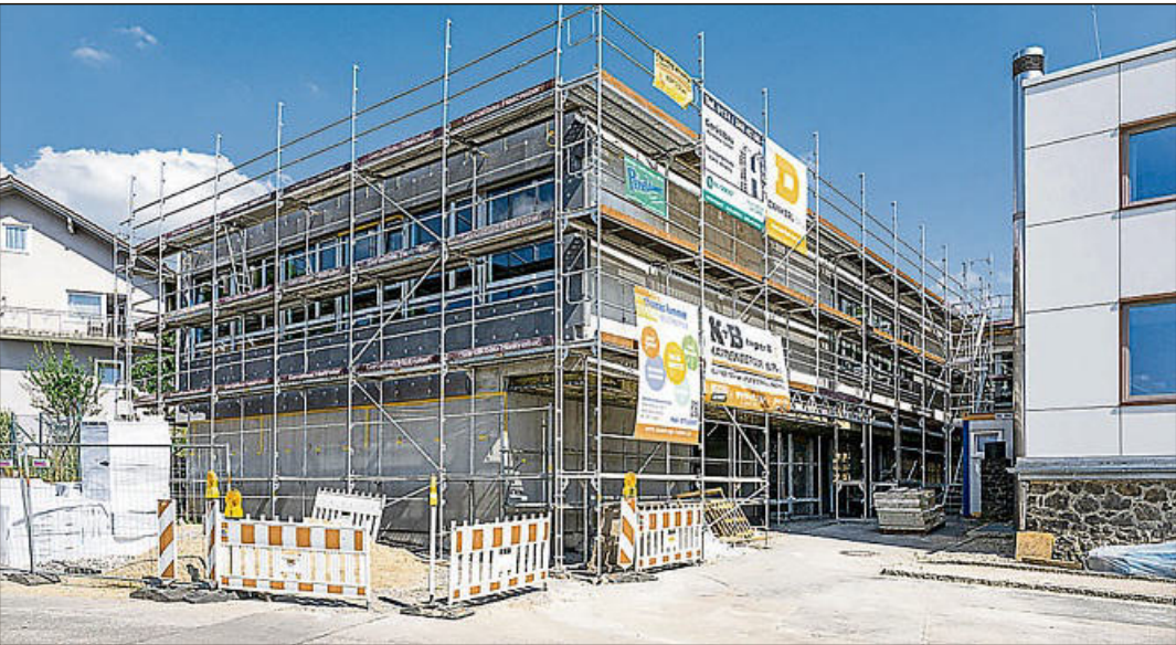
Die neue Diensthundeschule in Herzogau im Bauzustand.
