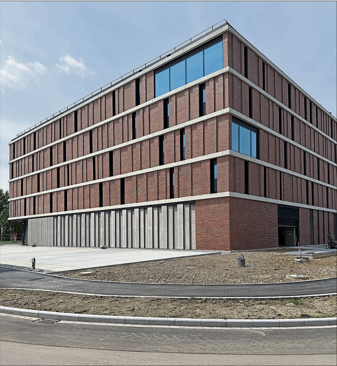
Die markante Klinkerfassade der neuen Polizeiinspektion ist bereits von Weitem gut sichtbar.
