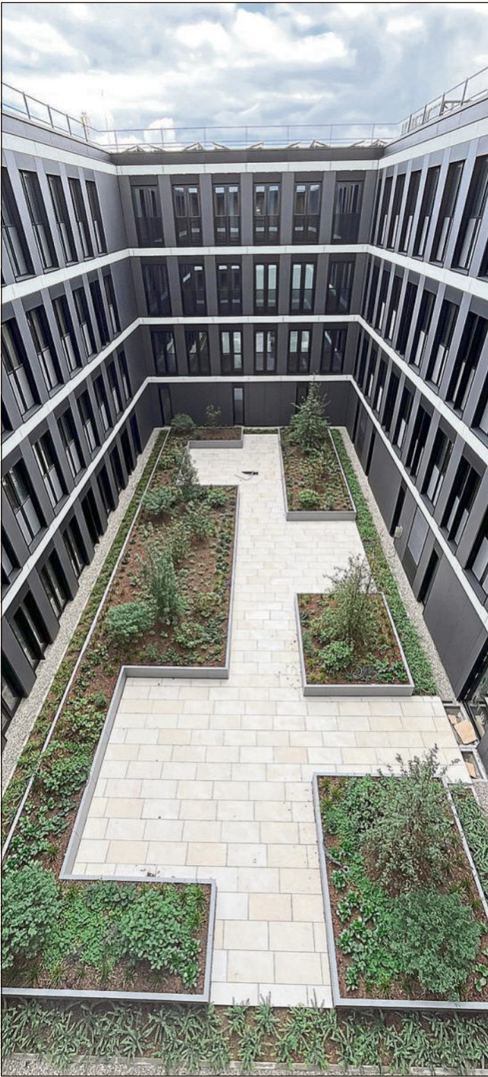
Blick von oben in den begrünten Innenhof.
