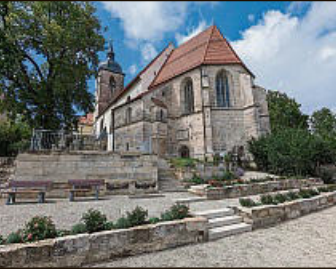
Außenansicht der Kirche mit den Freianlagen.
