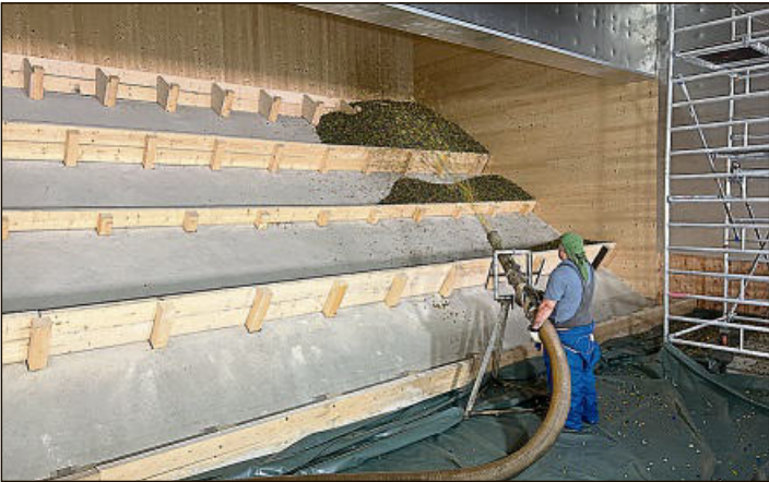
Einbringung des PU-Granulats im Geschossfang der Raumschießanlage. FOTO: BPR DR. SCHÄPERTÖNS CONSULT
