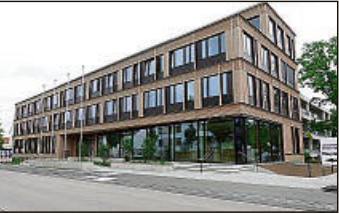
Der Erweiterungsbau. FOTO: WOLFGANG MÜLLER
