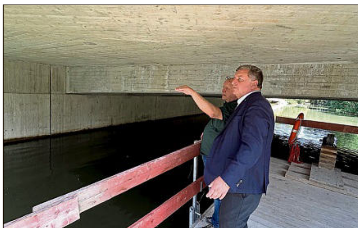
Sanierungsbedürftige Brücken stellen eine große Herausforderung bei der Modernisierung der Infrastruktur dar. Nicht auf den ersten Blick offenbaren die Bauwerke oft ihren Zustand.
