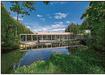
Die neue Mehrzweckhalle. FOTO: OLIVER HEINL
