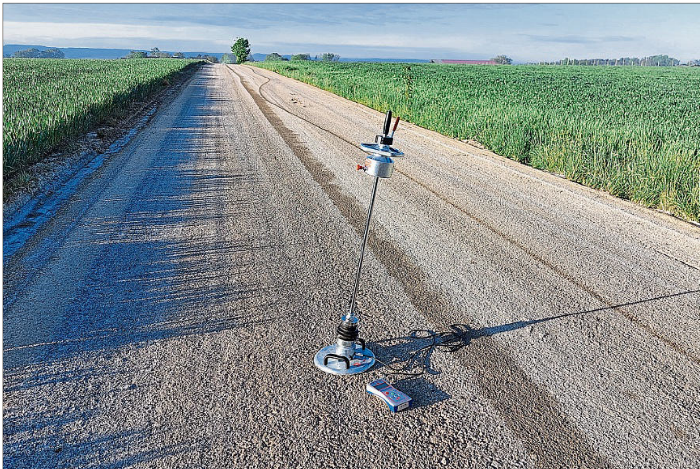
Messgerät zur Kontrolle der Tragfähigkeit nach Bodenaustausch und Verdichtung in Saal an der Donau.
