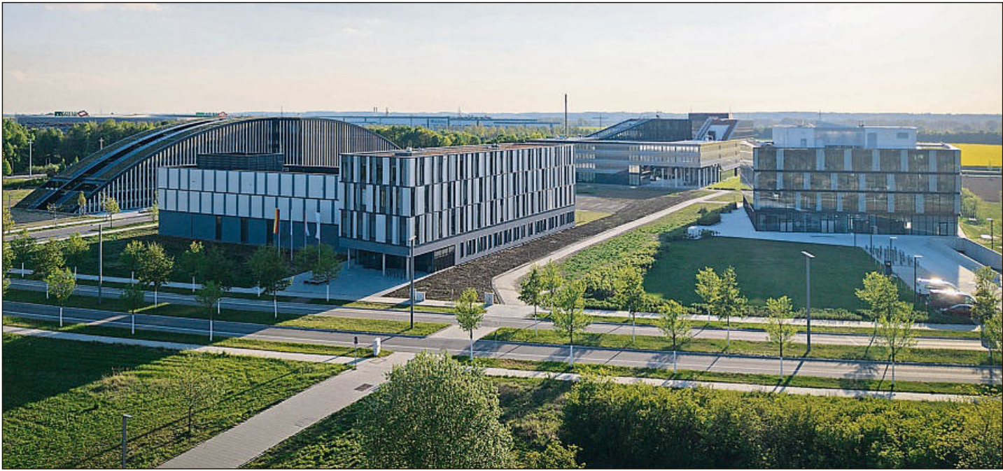
Das neue Gebäude des DLR-Instituts aus der Luft gesehen.
