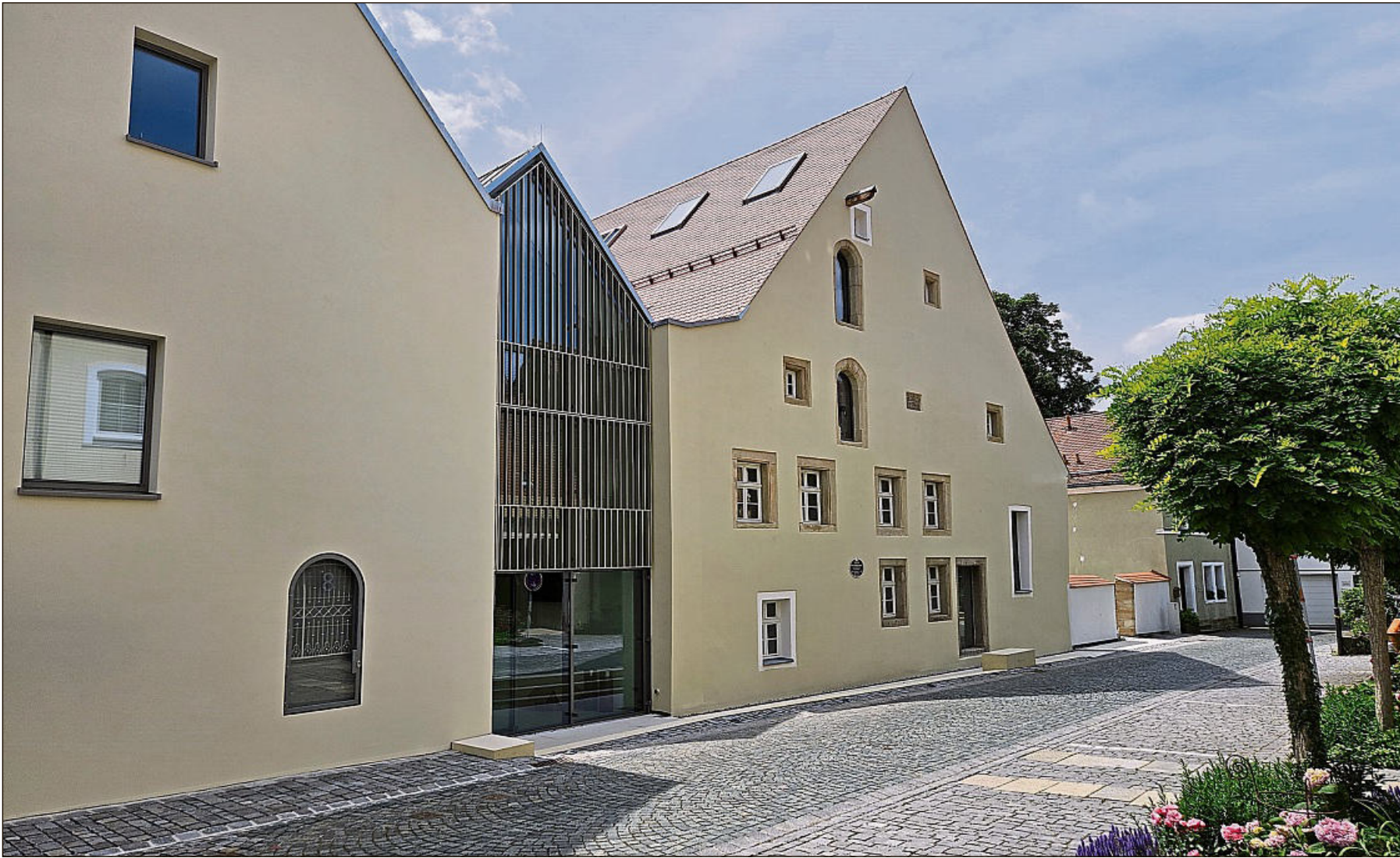
Aus einem fast verfallenen Denkmal ist ein Ort der Zukunft geworden.
