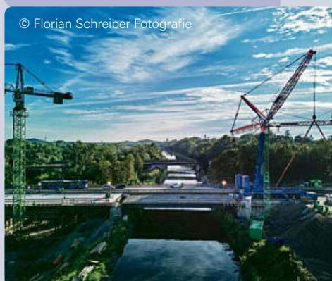
Herzog-Heinrich-Brücke am Föhringer Ring, München
