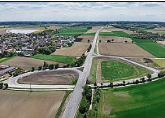
Die fertiggestellte Anschlussstelle Haunersdorf. FOTO: STAATLICHES BAUAMT LANDSHUT
