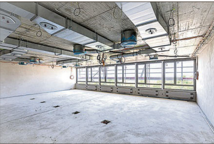
Blick in das noch nicht fertige Gebäude.
