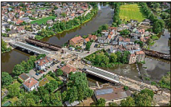
Das Brückenprojekt in Schwandorf. FOTO: OLIVER HEINL
