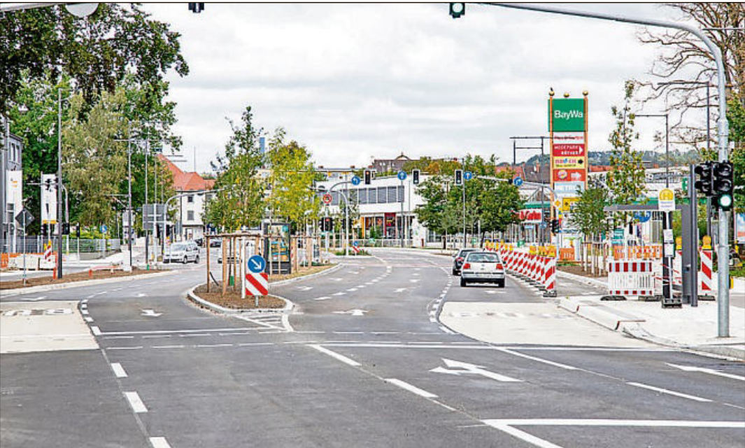
Die umgebaute Reuttier Straße.
